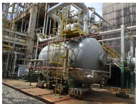
ภาพที่ 2-31 ระบบท่อขนส่ง Vent Gas และ Nitrogen
