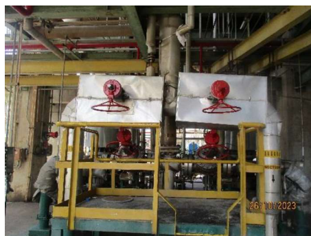
ภาพที่ 2-2 ระบบวาล์วควบคุมระหว่างถังปฏิกรณ์
