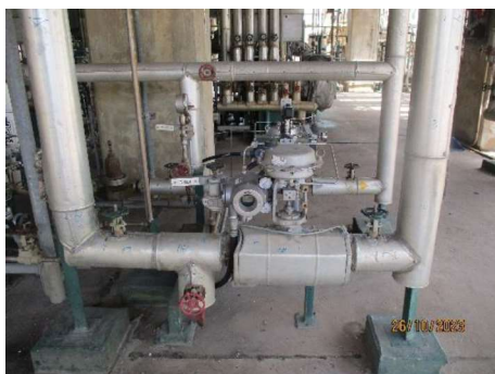
ภาพที่ 2-2 ระบบวาล์วควบคุมระหว่างถังปฏิกรณ์
