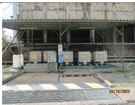
ภาพที่ 2-10 ถึง H_2SO_4 สำหรับปรับ pH ที่ API Separator
