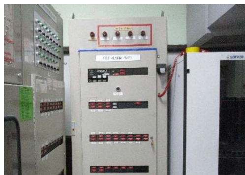
ภาพที่ 2-20 Gas Detector และแผงแสดงสัญญาณในห้องควบคุม
