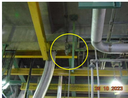
ภาพที่ 2-22 Heat Detector
